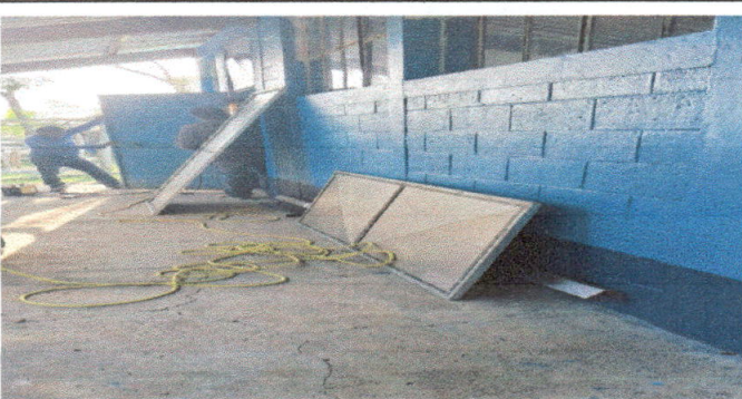
Foto 6: Se observa en la fotografía la instalación de la puerta de la dirección.
