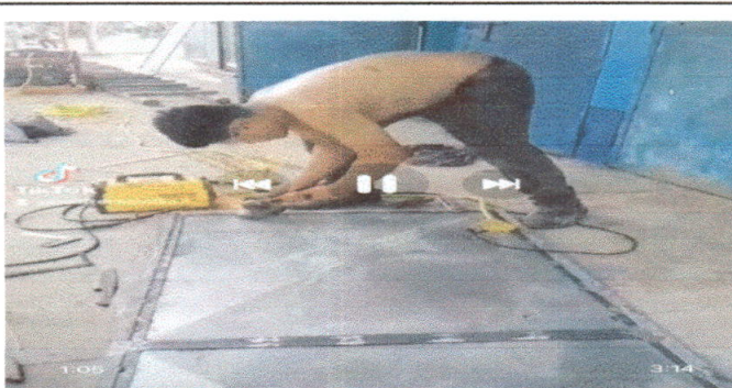
Foto 4: Se observa en la fotografía la instalación de la puerta metálica del baño.
