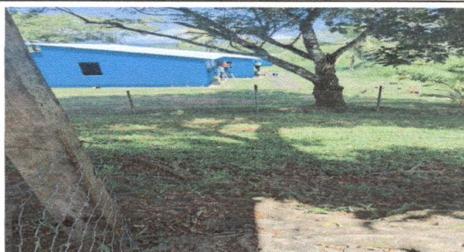
Foto 2: Se observa en la fotografía el avance de la pintada exterior de la pared de la escuela
