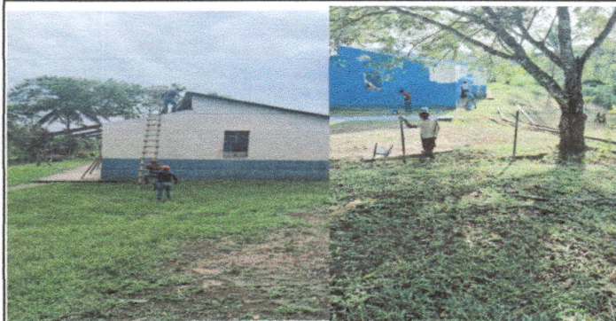
Foto 1: Se observa en la fotografía el avance físico del techado y pintada de la pared de las aulas.
